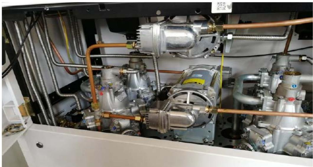
图 4-2 加油（二次）油气回收系统实景
